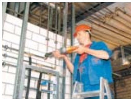
Lavorazione conforme alle esigenze pratiche.
