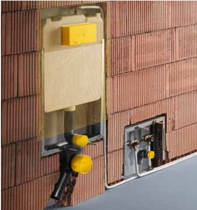
Montaggio di Viega Mono Tec WC e Viega Mono Tec Bidet ad incasso nella parete.
