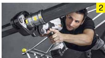
1. Il dispositivo di sicurezza SC-Contur evidenzia i raccordi non pressati già durante la prova di tenuta.
