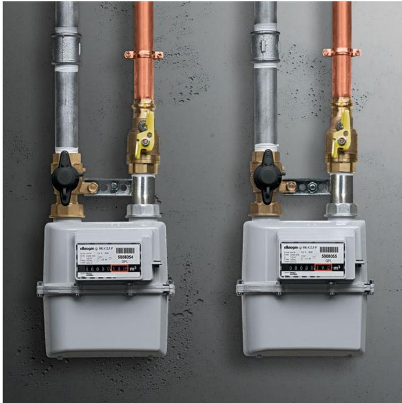
Fig. 1-1 Esempio di installazione di impianto a gas con Profipress G
