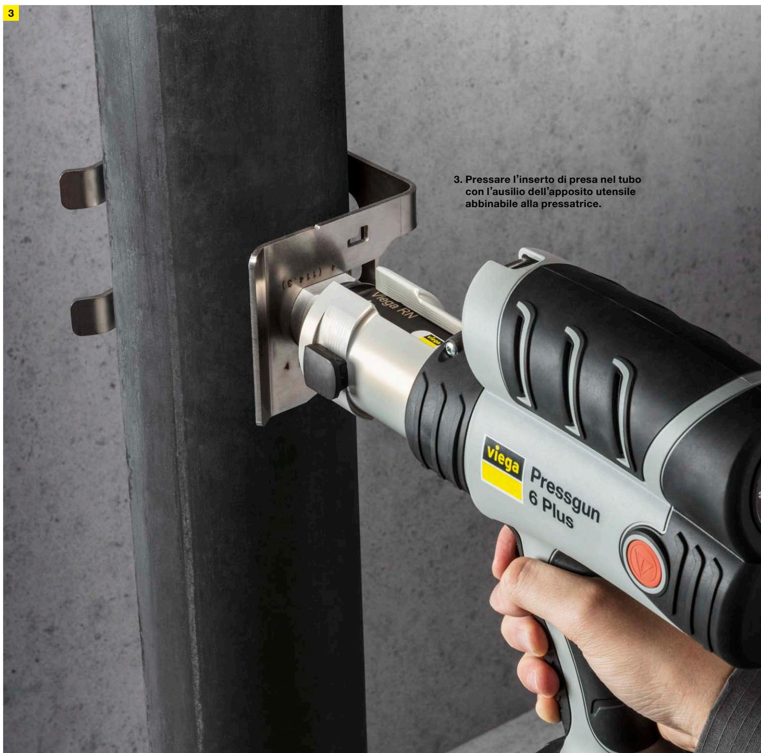
3. Pressare l'inserto di presa nel tubo con l'ausilio dell'apposito utensile abbinabile alla pressatrice.
